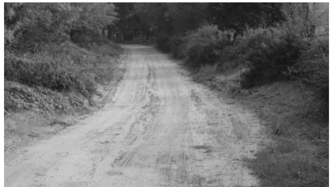
Elkészült a feketeteréti földút teljes kátyúzása
